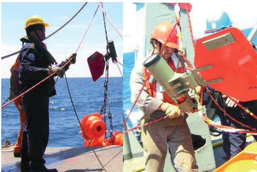
Figura 7.1. Instalación de un correntómetro mecánico.
